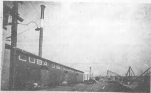
Depósitos y Muelle en construcción de la "Cuba Destilling Company".
