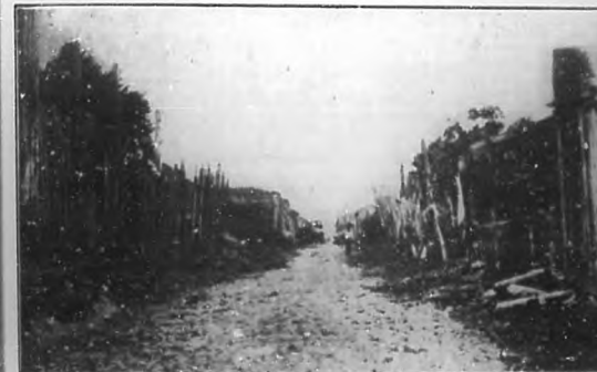
La calle de Perdomo, antes de ser reconstruida.
