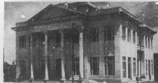
El nuevo Palacio Municipal, que ocupa la manzana donde existió el Mercado "Creci", que fué demolido.
