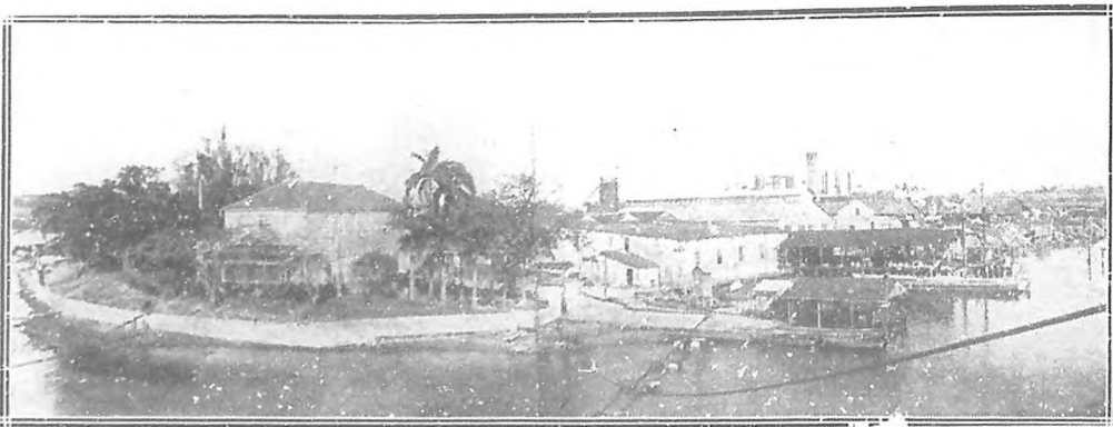
Vista panorámica de la Refinería Belot.
